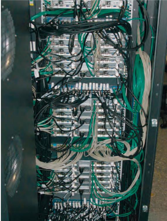
**Abb. 3: Cluster-Verkabelung: schwarz: Infiniband, grau: Gigabit-Ethernet, grün: Service-Netz**
